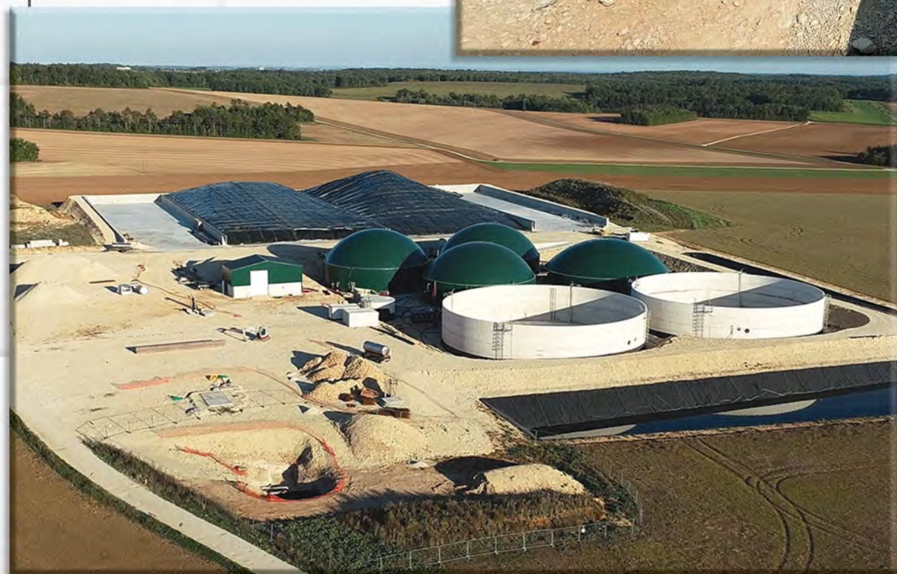
Vue générale d'un méthaniseur
