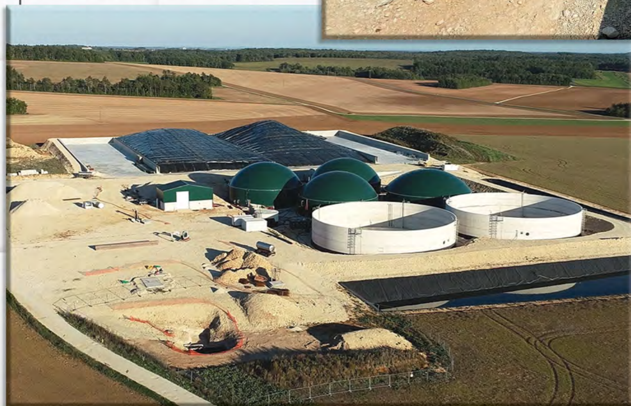
Vue générale d'un méthaniseur
