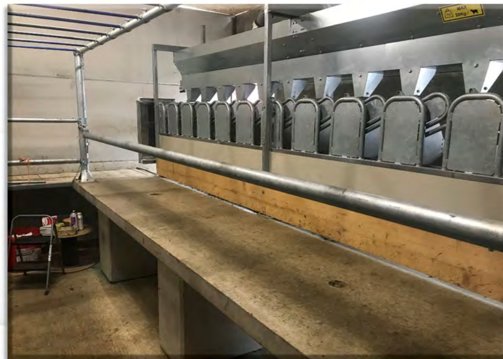
Dalle préfabriquée Epaisseur 10 cm posée sur TETRA BLOC.
