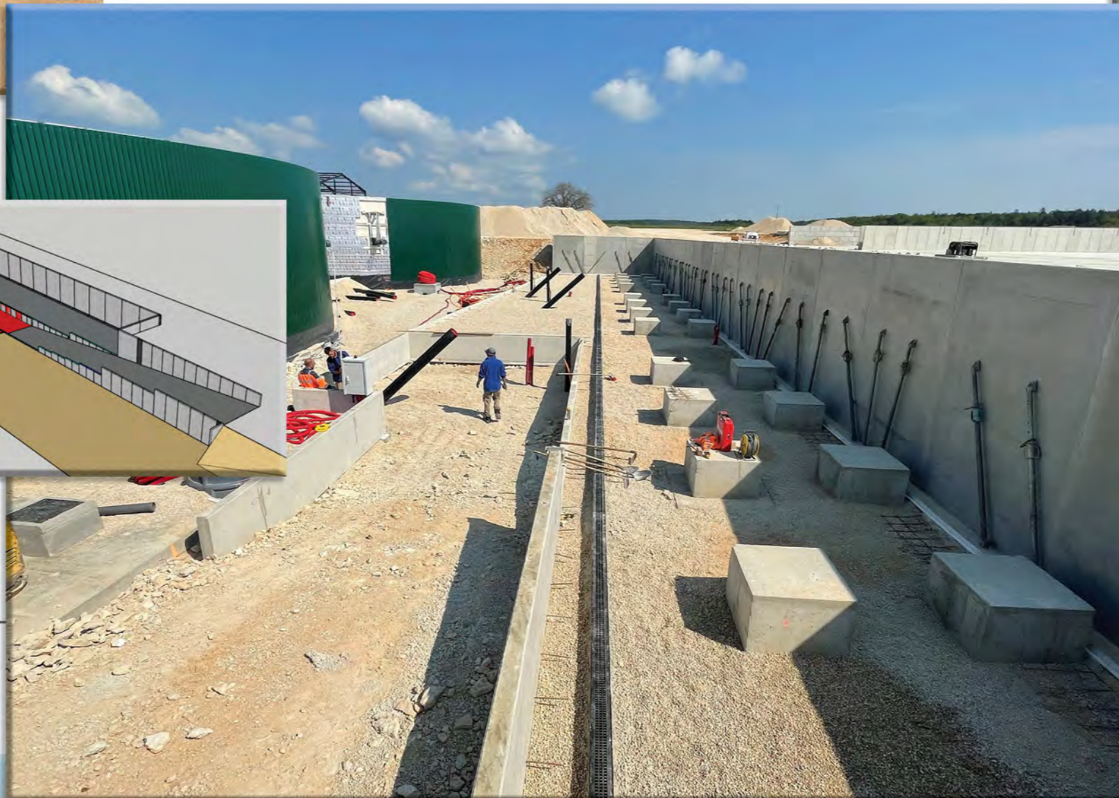
Coulage de massif Création de murs pour la surprofondeur Mise en place de longrines de séparation Dalle de répartition sur fosse
