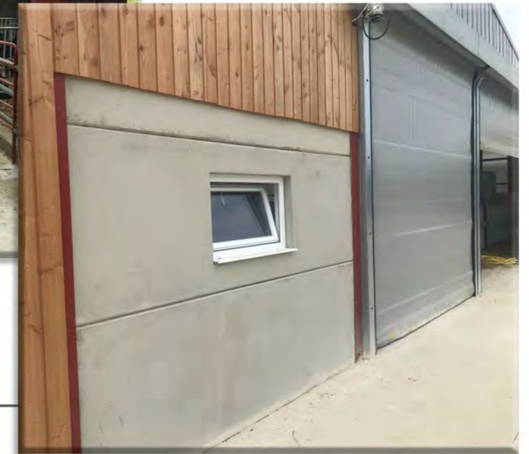
Réservation sur mur préfabriqué pour la mise en place de menuiserie.
