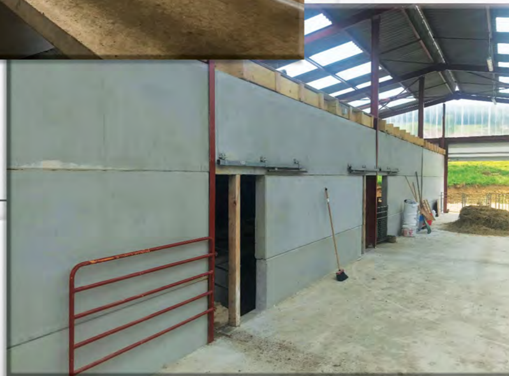
Murs de bardage préfabriqués Epaisseur 14 cm.
