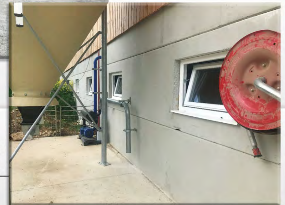
Dalle coulée en place pour supporter le silo.
