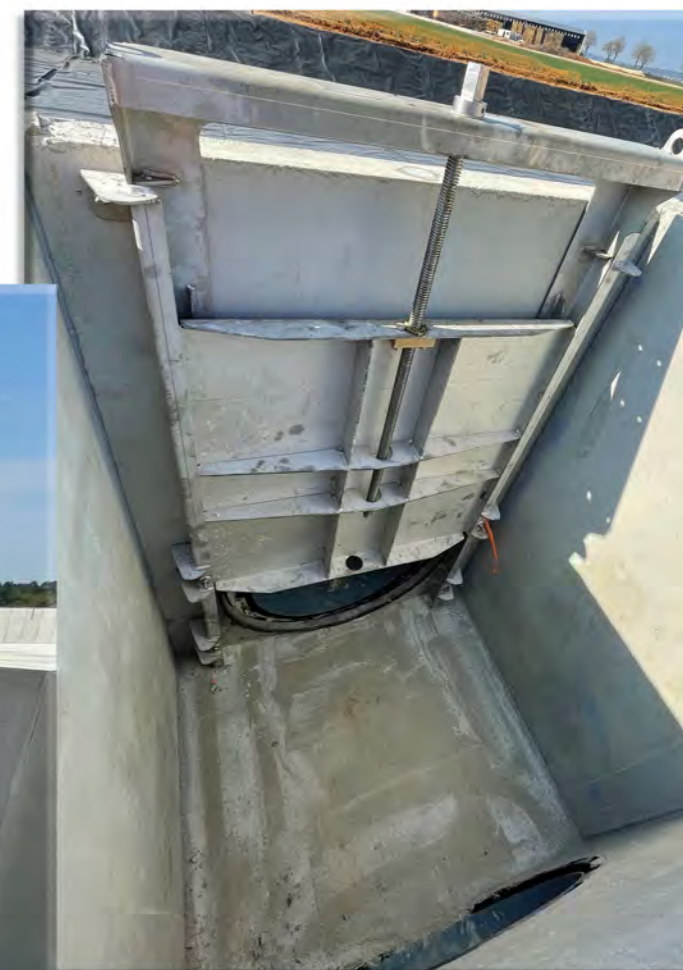
Création d'un regard préfabriqué pour accueillir une vanne DN1000
