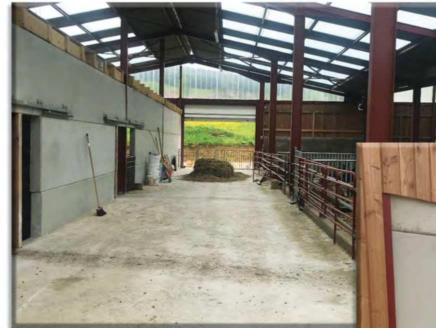
Réservation sur mur préfabriqué pour la mise en place de menuiserie.
