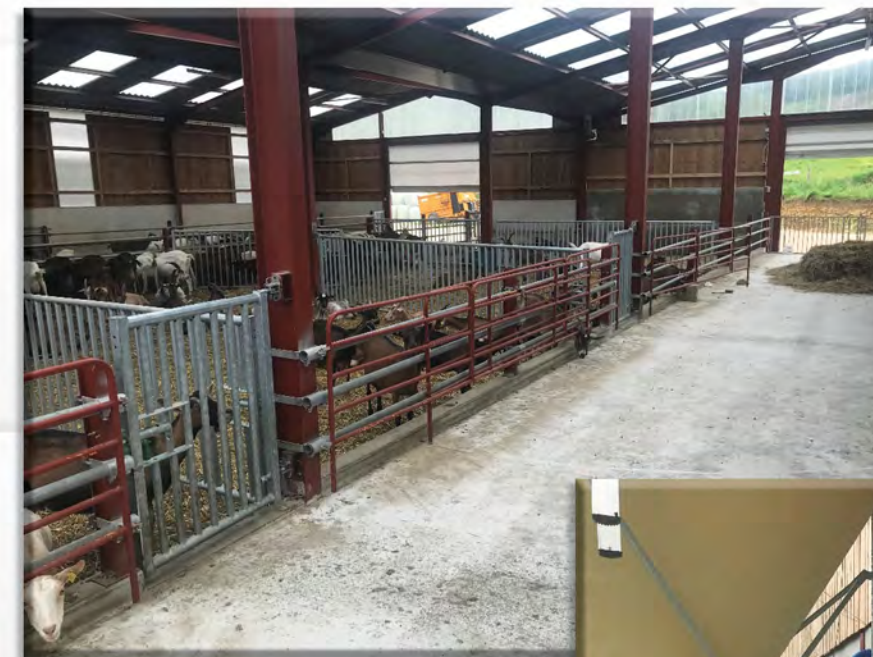
Longrines préfabriquées section 15 x 50 avec réservations pour les portillons.
