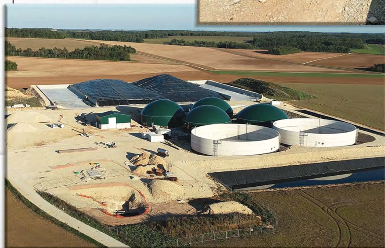
Vue générale d'un méthaniseur
