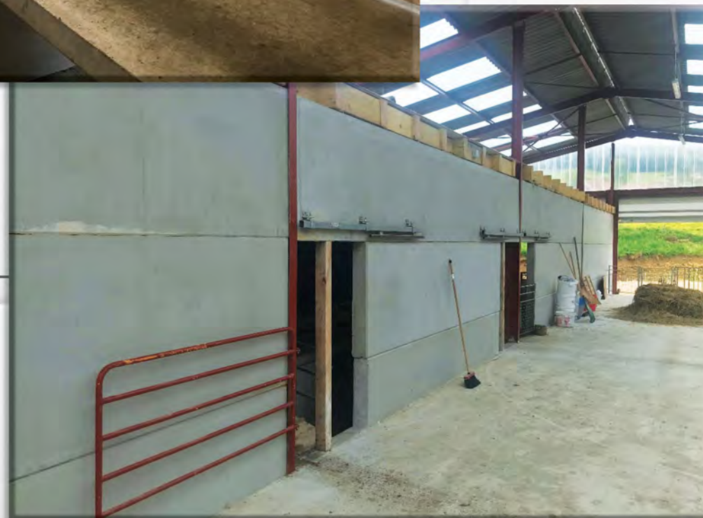
Murs de bardage préfabriqués Epaisseur 14 cm.
